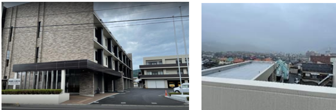
図 2-3 愛媛県南予地方局大洲庁舎の外観(左)と設置位置付近の様子(右)
