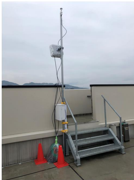
図 4-17 ローカル 5G 基地局の写真と諸元
