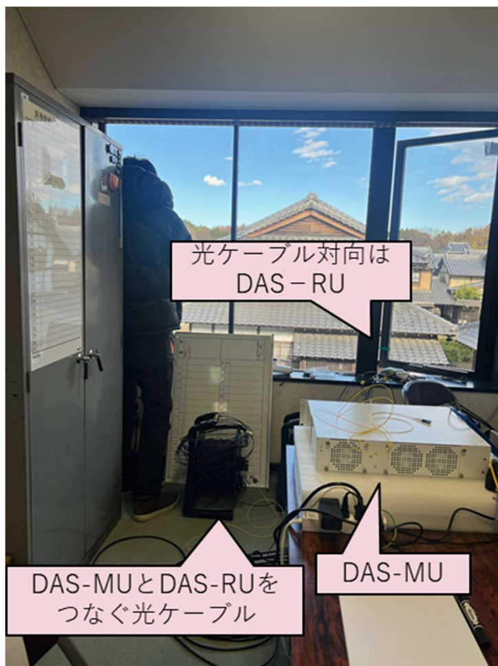
図 2-12 DAS MU 接続用基地局設置(実施環境に即する)
