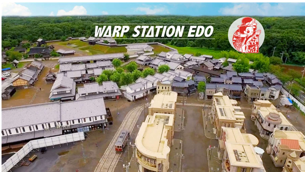
図 2-1 ワープステーション江戸 航空写真
