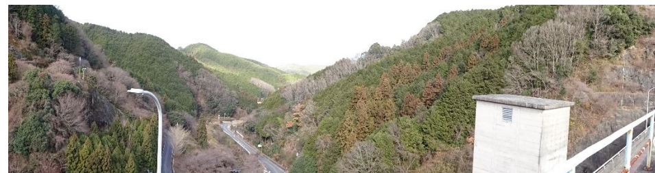
下流側(北西方向)
