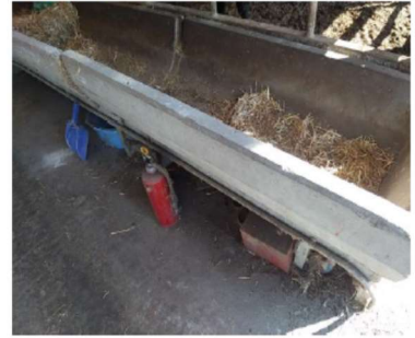
飼槽(コンクリート)
