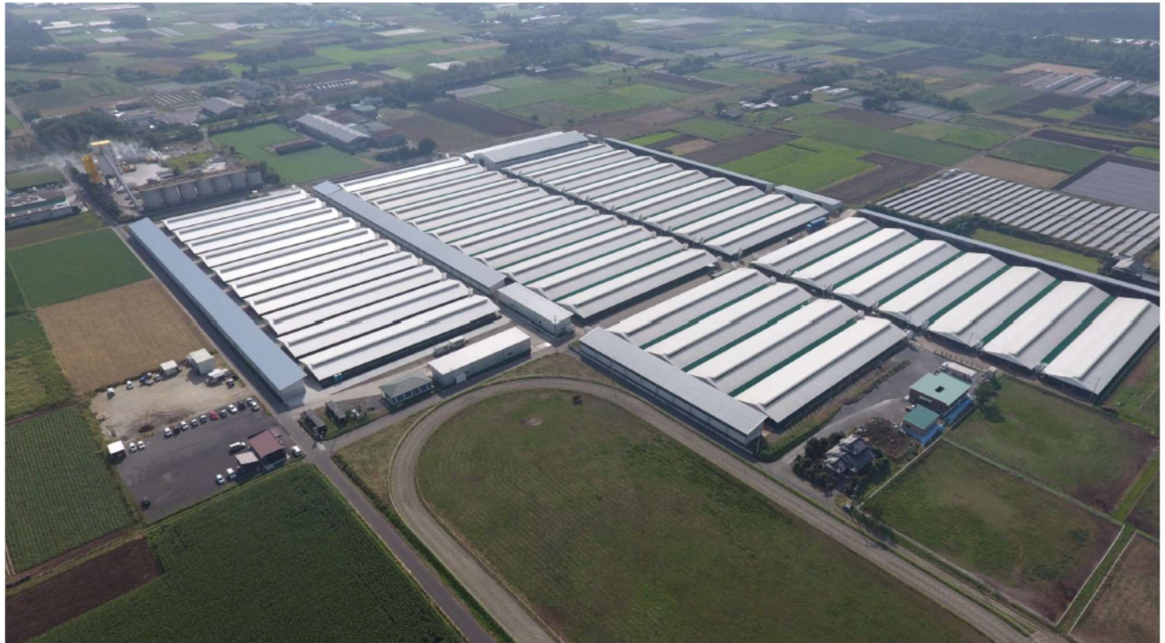
図 2.2-1) 大隅ファーム牛舎外観
