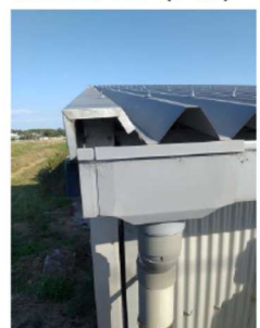
屋根はトタン(鉄板)
