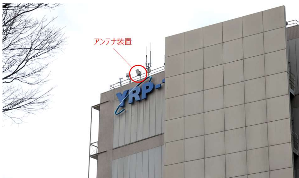
図 3-2 アンテナ装置の設置状態
