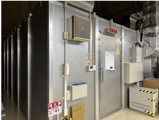
無線回路、スループット・伝送遅延測定に用いるシールドルーム
