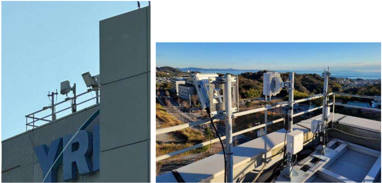
図 3.2-5 屋外基地局(アンテナ)の設置環境
