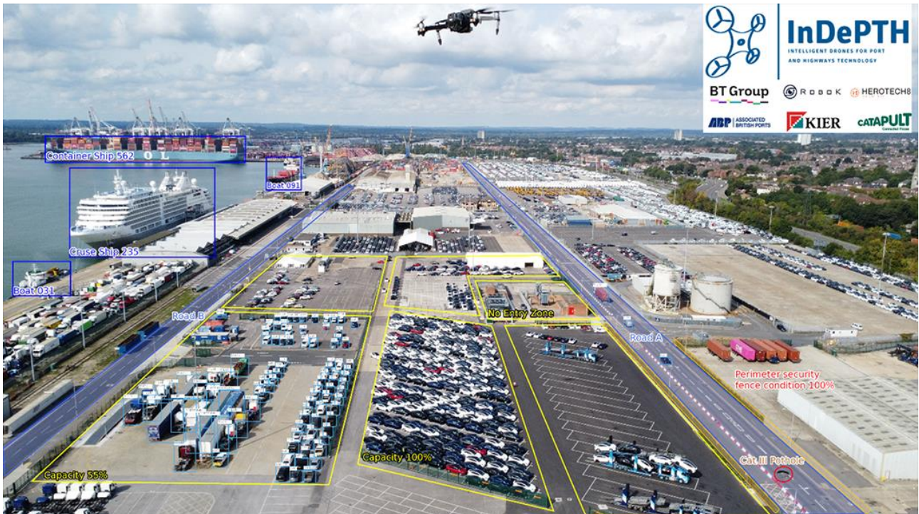
図 5-19 サザンプトン港(英国)におけるドローンによる港湾施設常時監視(イメージ)
