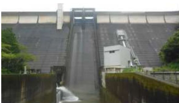
天理ダム（放水側）外観
