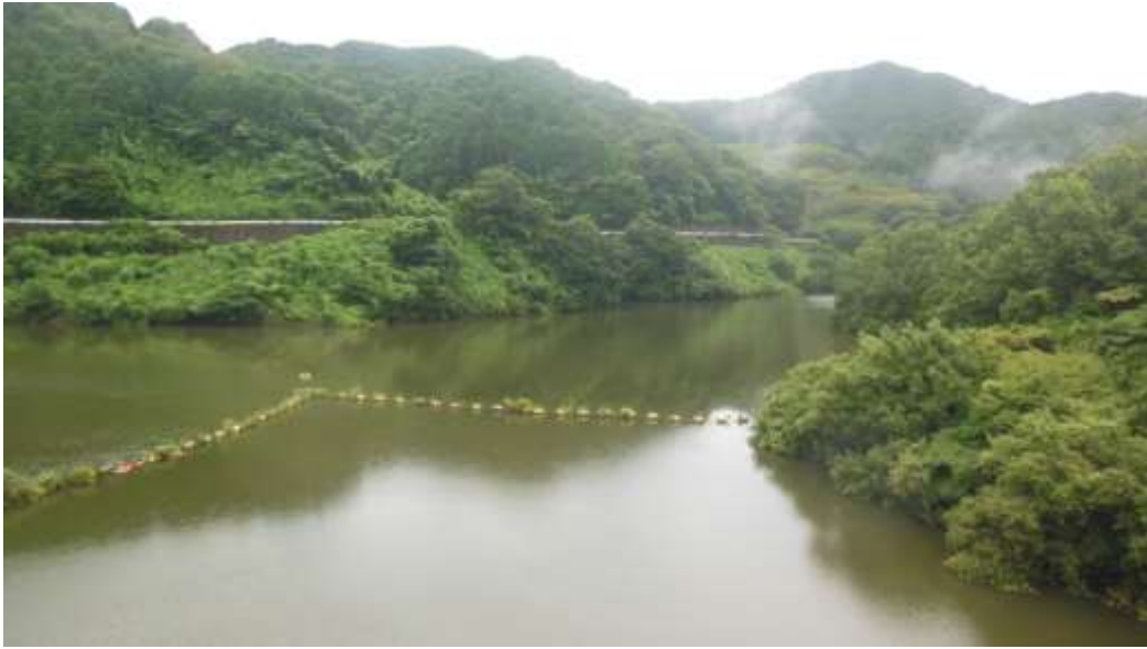
図 2-4 天理ダム堤体上部から上流方向の様子
