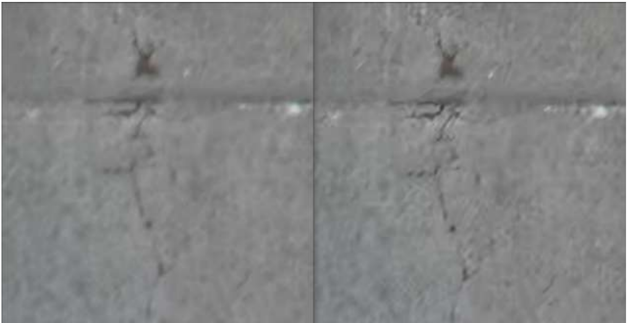
図 4-40 ヒビ部の AI による超解像処理 (左:元画像 右:AI 超解像処理)
