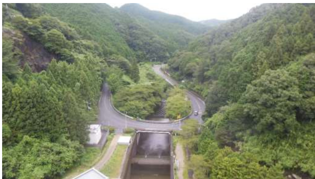
図 2-3 天理ダム堤体上部から下流方向の様子
