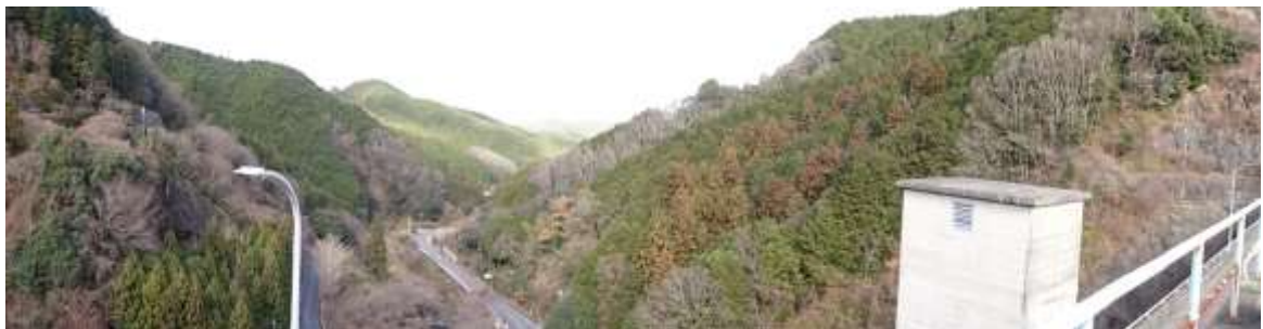
図 3-2 基地局アンテナ設置場所から見た下流側
