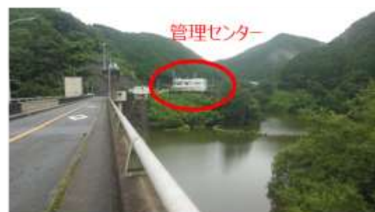
天理ダム（貯水側）水面と管理センター
