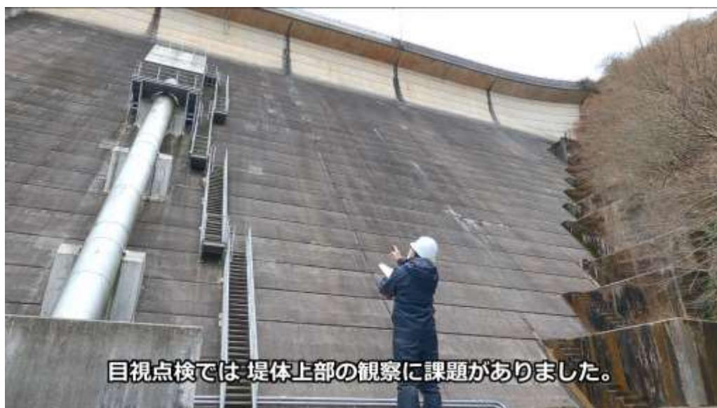
図 5-2 説明映像 ダムの目視点検
