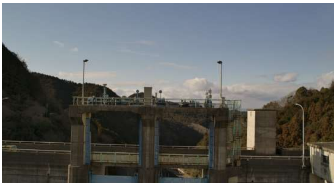
図 4-13 ローカル 5G を介してのドローンに搭載の 8K カメラ 実際の映像(堤体側)
