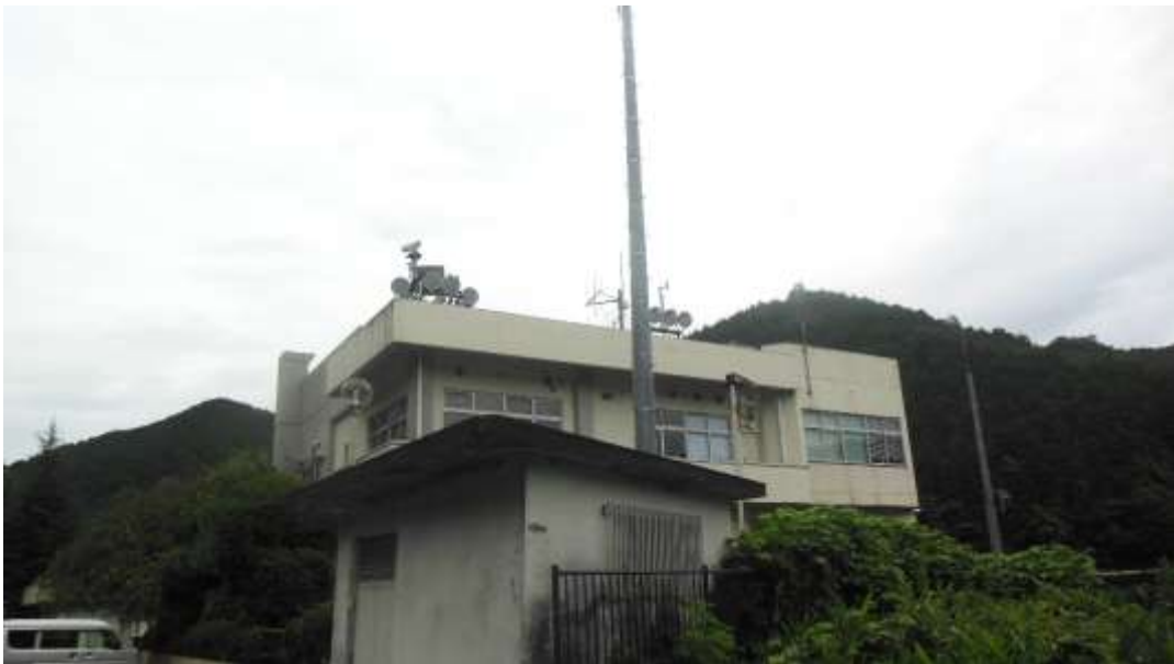
図 2-5 奈良県天理ダム管理センター外観
