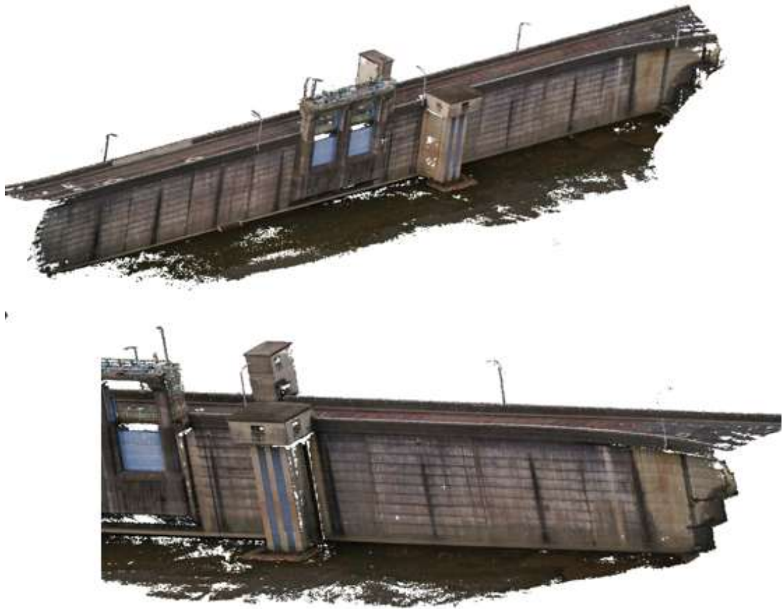
図 4-45 3D データ画像(ダム壁面に向かって左斜め上から(上)・右斜め上から(下))
