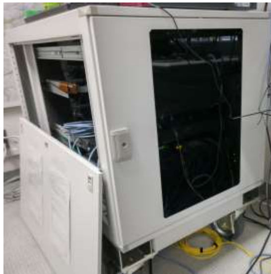
図 2-8 天理ダム管理センター内に設置したコア及びベースバンドユニット(BBU)
