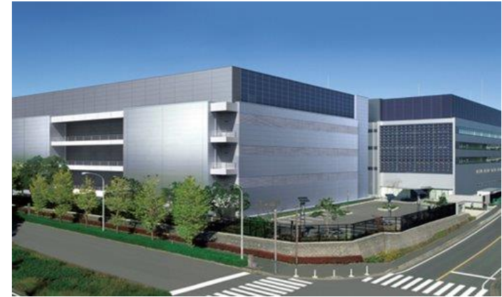
横浜データセンター建屋
