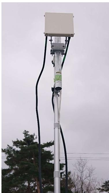
図 3.3.74 ドナーアンテナ設置状態
