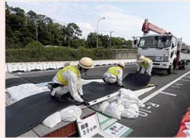
道路啓開訓練
