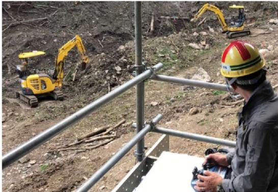
無人化バックホウによる既設堰堤の除石作業状況
