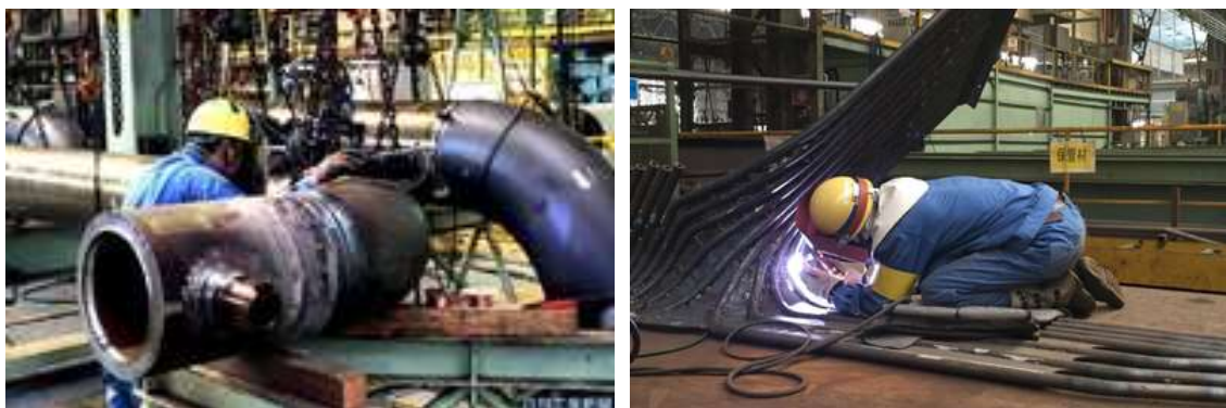
図 4-3 IHI のボイラの主力製造拠点である相生工場 1213
