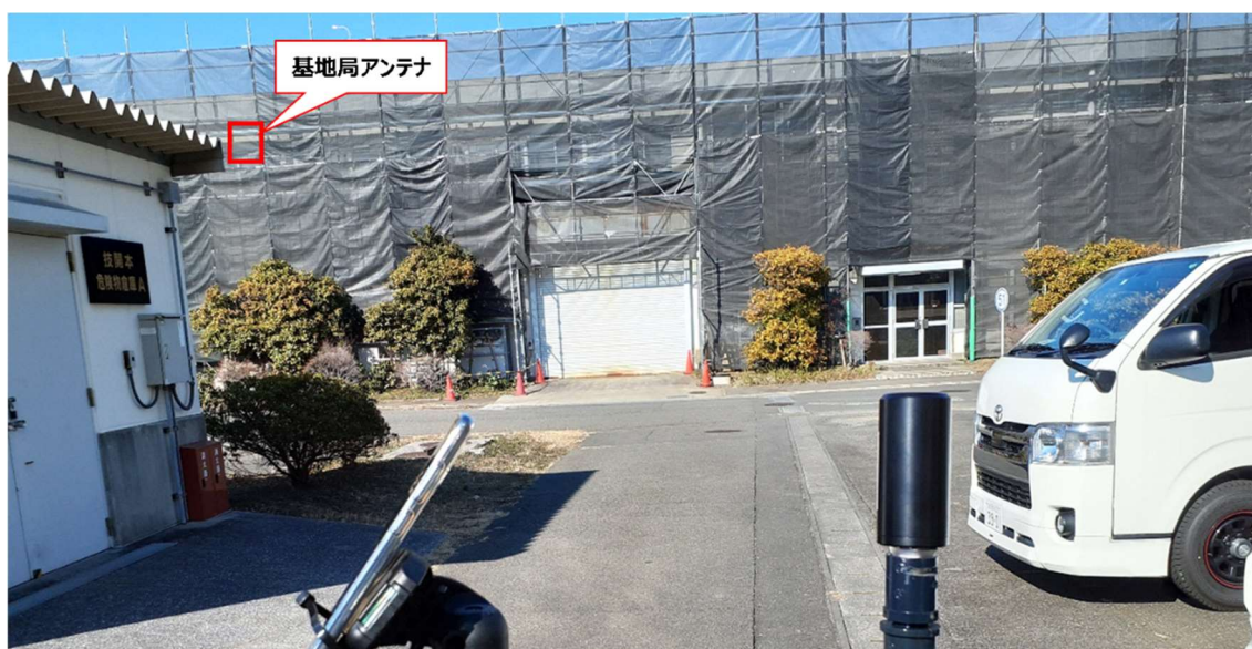
図 3-46 屋外参照点の状況
