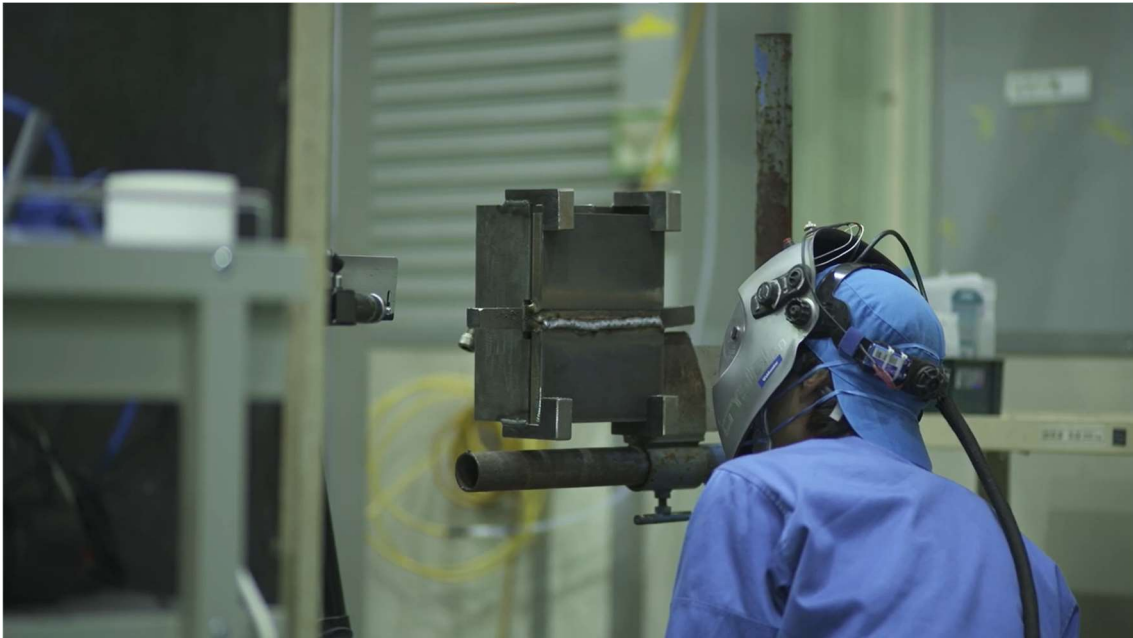
図 4-38 溶接士が遠隔指導によって溶接作業を行っている様子
