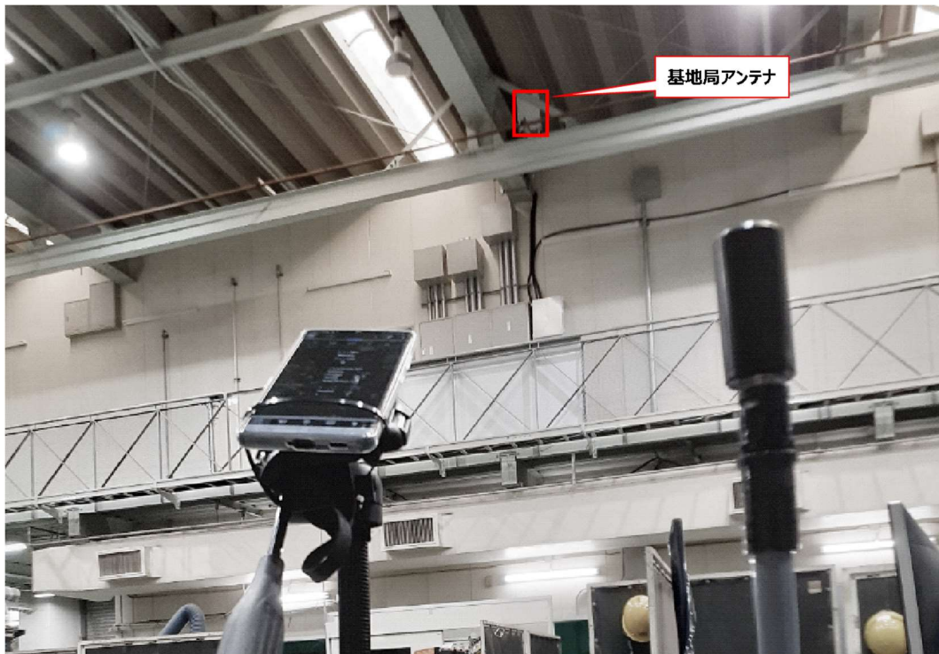
図 3-32 工場壁面の様子
