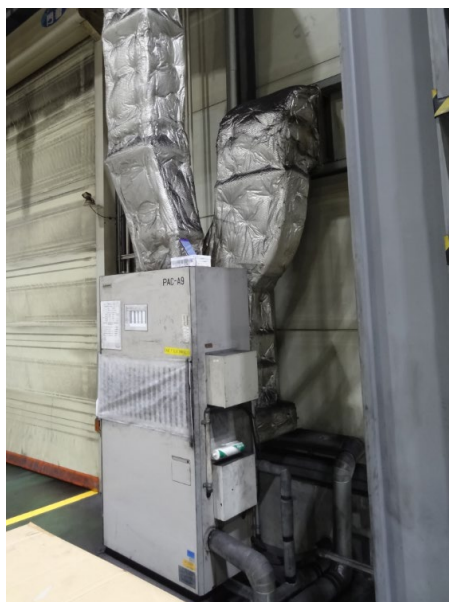
図 5.4-5 測定点 59(NLOS)の測定の様子
