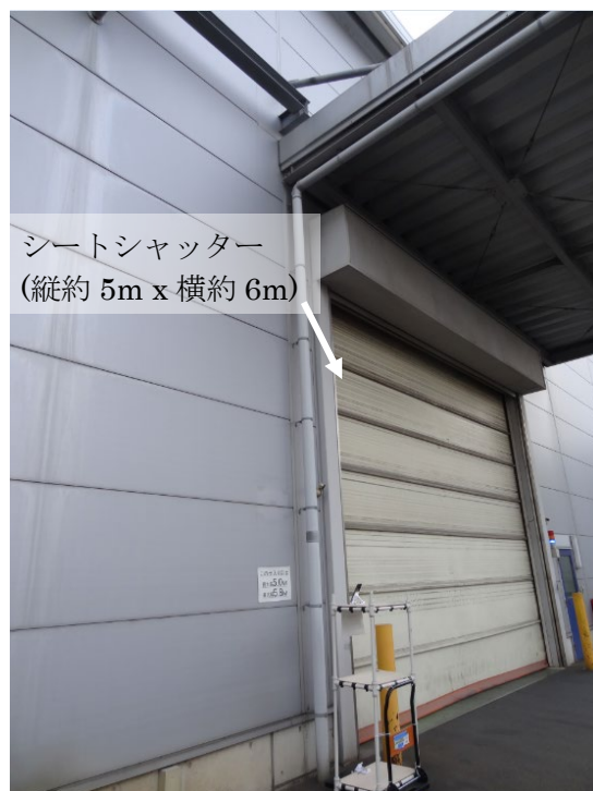
図 5.3-94 D 棟北側のシートシャッターの外観
