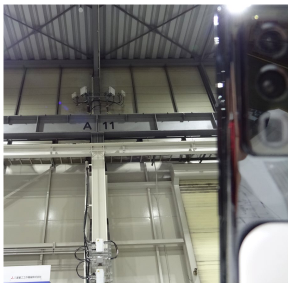
図 5.3-5 測定点 1(LOS)での測定の様子
