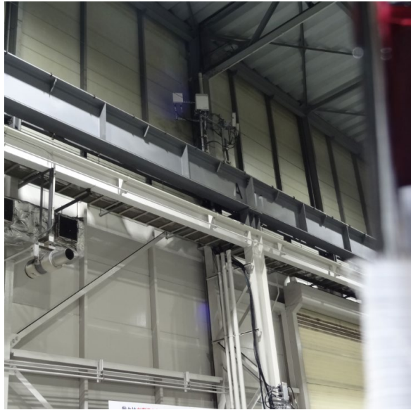
図 5.3-6 測定点 2(LOS)での測定の様子
