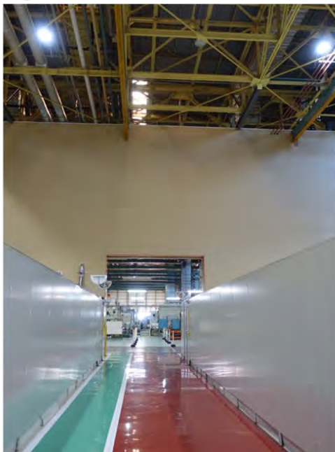
図 2-6 エリア境界の壁 (石膏ボード)
