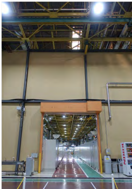
図 2-6 エリア境界の壁 (石膏ボード)
