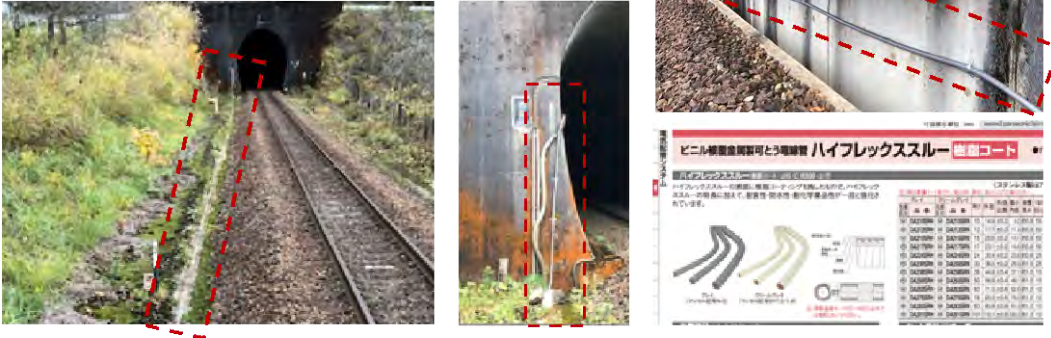
図 6.3-1 施設の共同利用による光ファイバ敷設の事例
