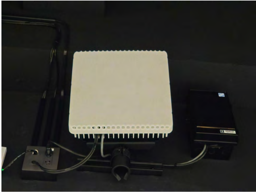
図 4-6-1-1 基地局の設置風景
