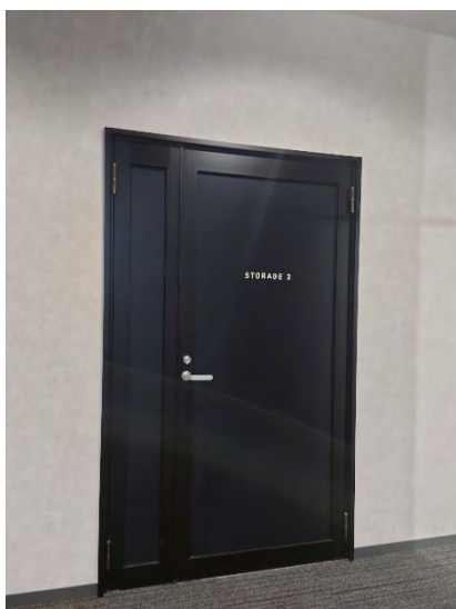
図 2-1 施錠可能なマシンルーム外観
