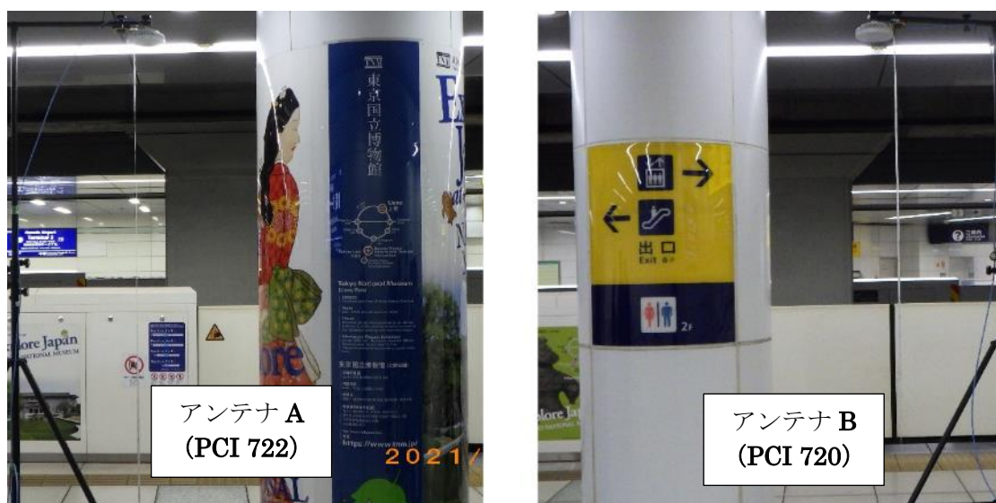
図 5.3.5.2-7 技術実証 4 アンテナ設置環境 (NLOS 環境)
