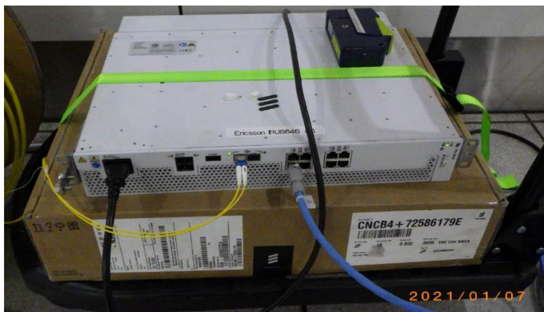
図 5.1.3.3-4 B2F 設置機器 (IRU) の設置風景
