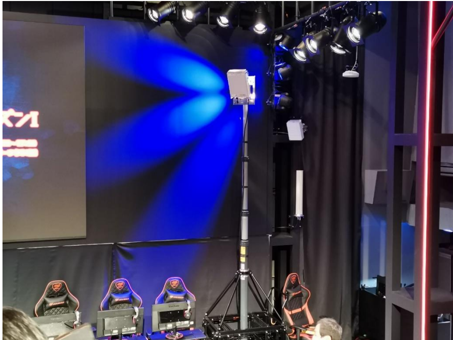
図 4-72 ローカル5G、LTE基地局、キャリア5Gの壁面等固定状況
