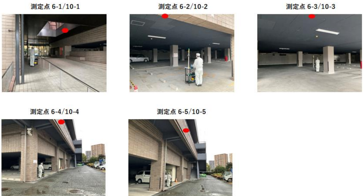
図 3.3-48 熊本市総合体育館南側測定点写真
