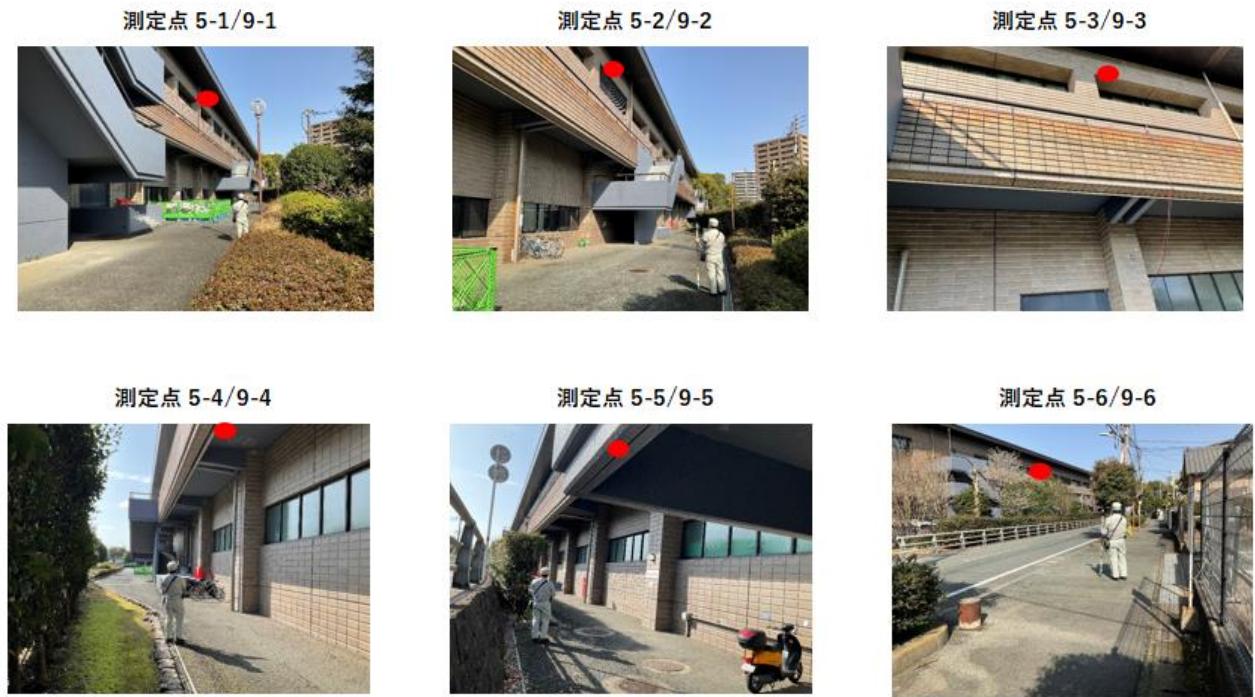
図 3.3-45 熊本市総合体育館東側測定点写真 1
