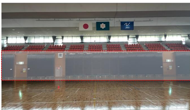
図 3.2-2 輻射式冷暖房装置及び設置位置
