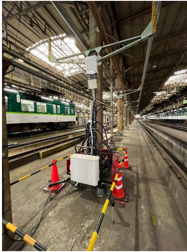
図 3. 2. 2-20 寝屋川車両基地内検査庫のキャリア5G 状況
