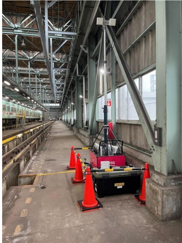
図 3. 2. 2-10 筑紫車両基地内検査庫のキャリア5G 設置状況
