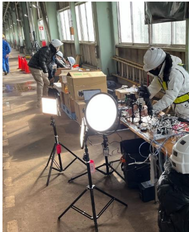
図 3. 2. 2-11 筑紫車両基地内検査庫の機材配置状況
