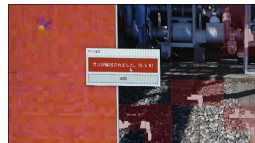
ガス漏れ検知画面
