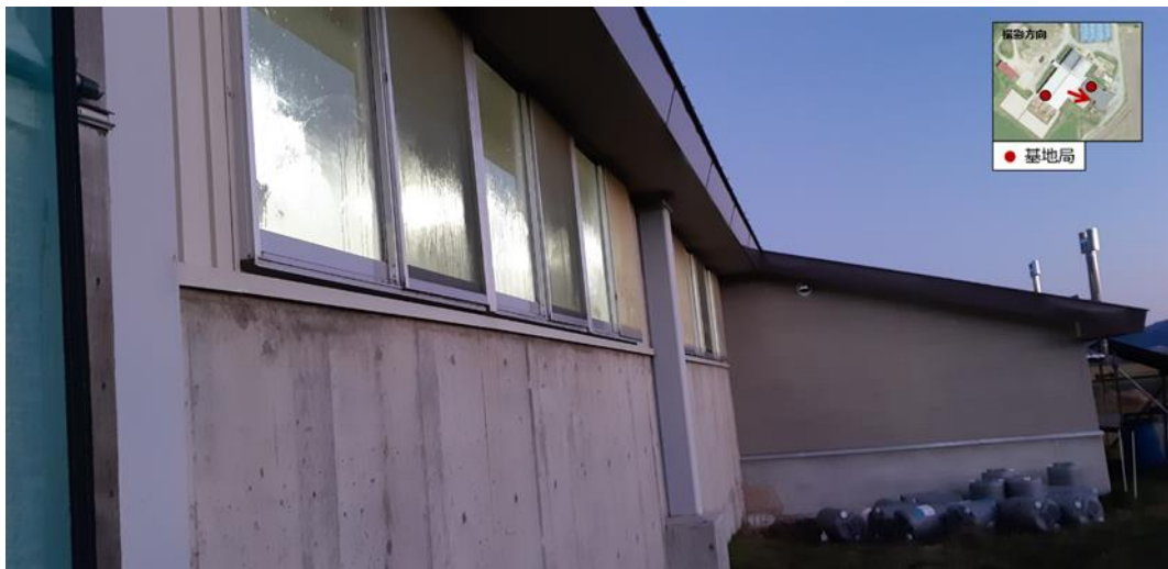
図 3.3.2.5-5(d) 壁面 4 (搾乳室、事務室等) 屋外参照点の状況
