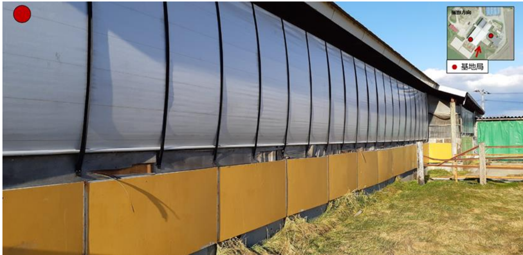
図 3.3.2.5-5(a) 壁面 1 (牛舎側) 屋外参照点の状況
