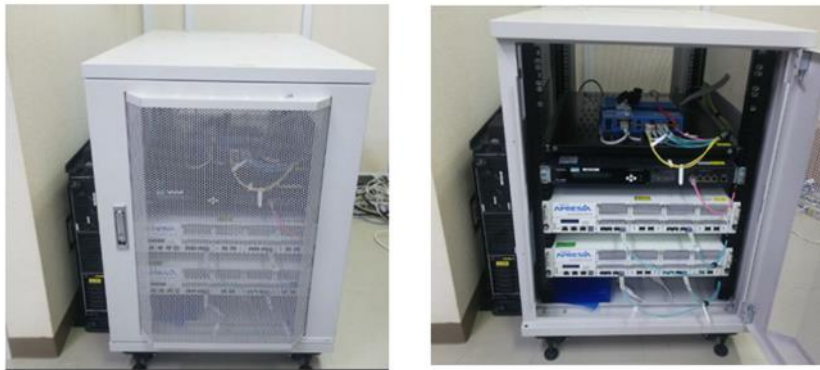
図 2.3.2-4 ローカル 5G システム設置状況 (牛舎事務所内)
