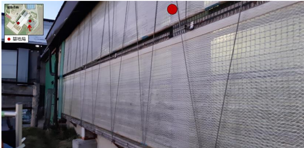
図 3.3.2.5-5(c) 壁面 3 (牛待機室側) 屋外参照点の状況
