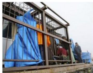
損壊した太子館の建物を補修する山小屋関係者ら＝富士山8合目
