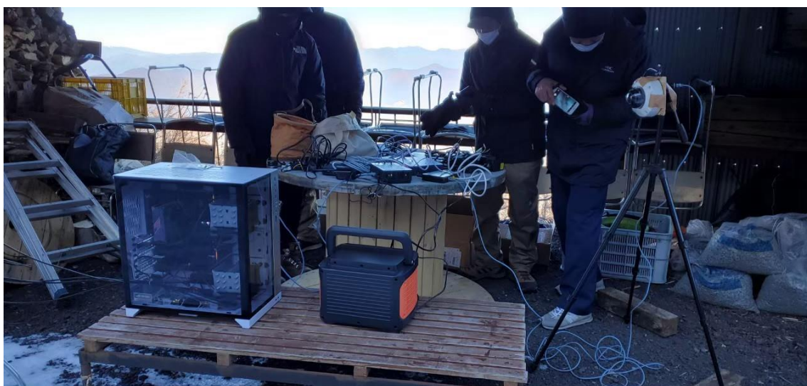
図 2-10 佐藤小屋に設置した一体型基地局 (FLARE 基地局) と AI カメラ
