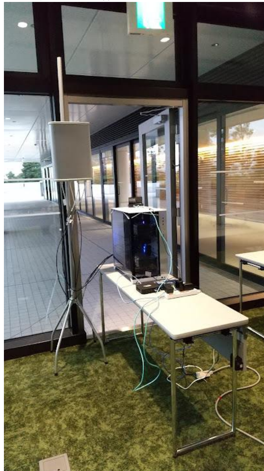
図表 2-9 FLARE SYSTEMS 製 可搬型ローカル 5G システム (およびアンテナ) パシフィコ横浜 2 階 ガーデンラウンジ C 設置
