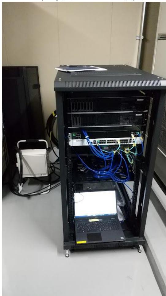
図表 2-5 NEC 製 無線制御装置 CU/DU サーバー、VPN ルーターおよびサーバーラックパ シフィコ横浜ノース MDF 室設置
