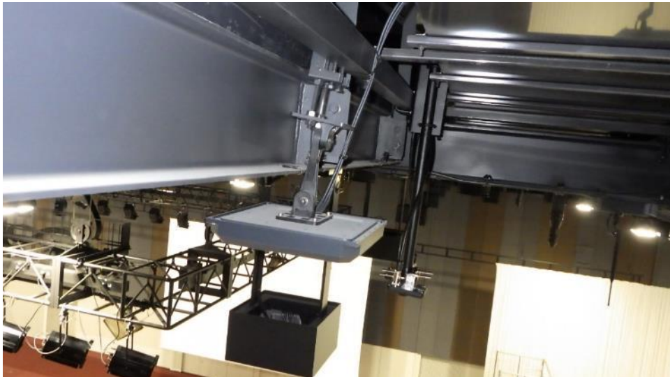
図表 2-8 NEC 製 無線装置 RU およびアンテナ パシフィコ横浜ノース 1F 多目的ホール キャットウォーク設置
