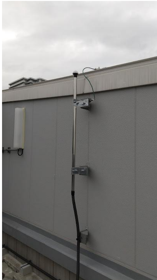
図表 2-4 GPS アンテナ パシフィコ横浜ノース屋上設置
