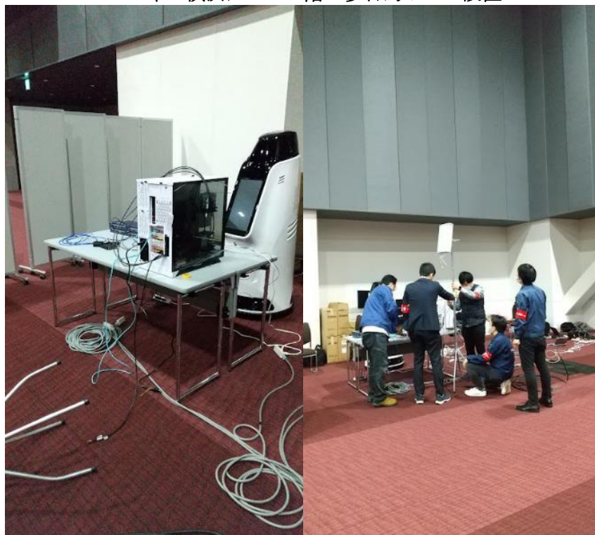
図表 2-10 FLARE SYSTEMS 製 可搬型ローカル 5G システム (およびアンテナ) パシフィコ横浜ノース 1 階 多目的ホール設置
