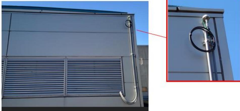
図 2.2.6-2 設置された GNSS Sync Kit (エリクソン社製)
