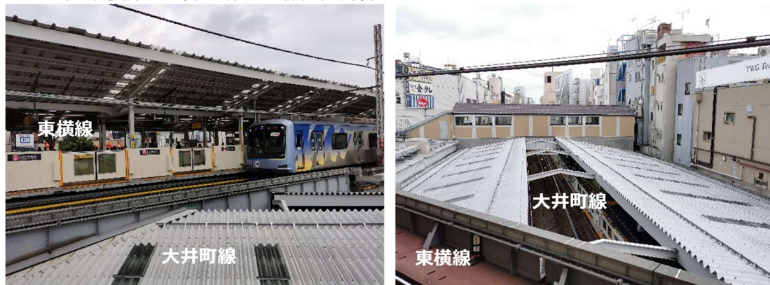
図3.2-5) 東横線と大井町線の立体交差部分
