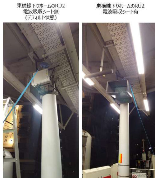
図 3. 3. 2. 5(4)3)-5 東横線下りホーム RU2 への取り付けの様子
