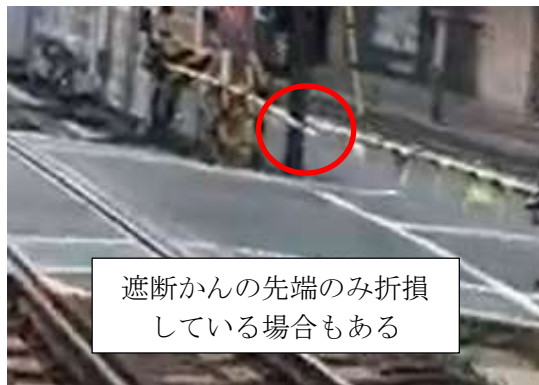
図 4.4.1.1(3) -4) 遮断かんの先端が折損(イメージ)
