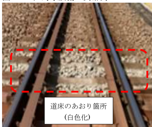
図 4. 4-1) 対象設備の異常例
