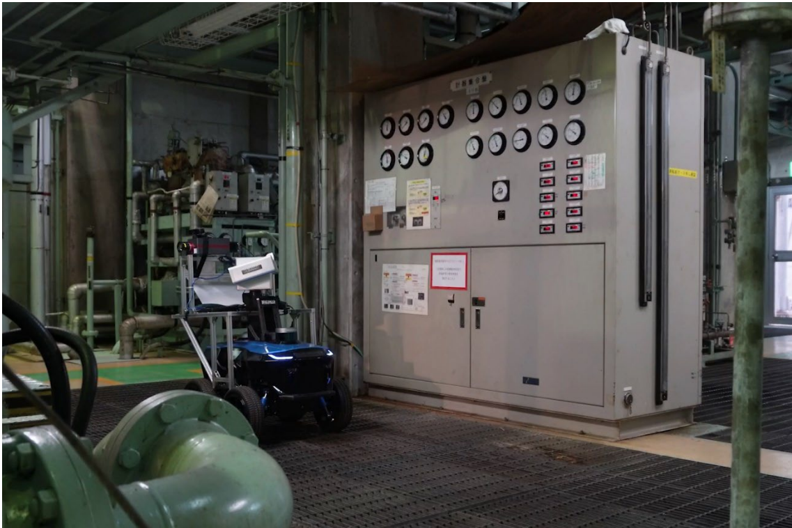
図 4.3-5 メータ点検する様子
