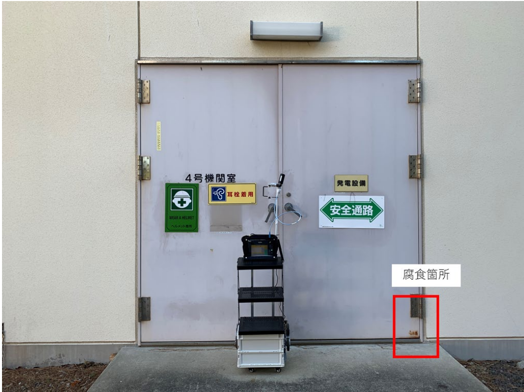
図 3. 3. 1. 4-4(d) 金属扉状態②
