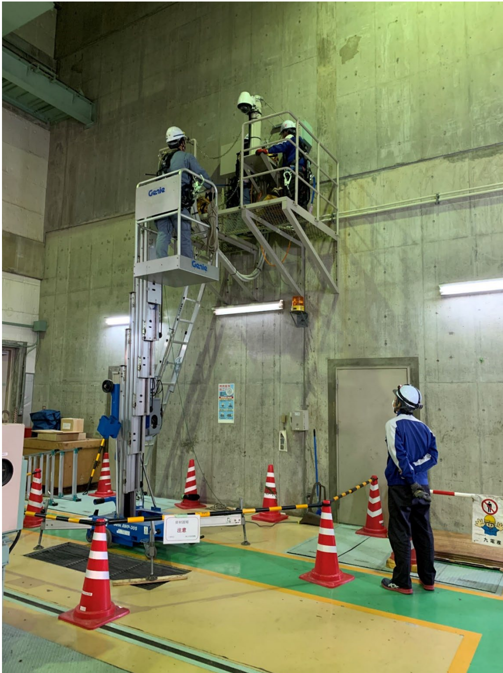
図 2.6-4 ローカル5Gアンテナ設置時における高所対応作業の状況
