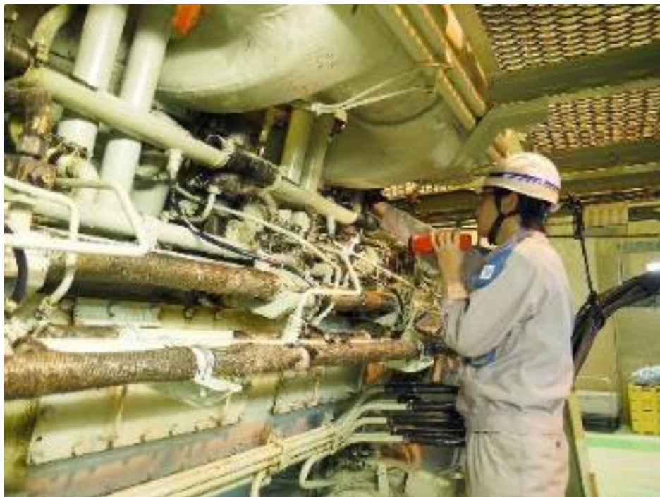
図 4.2-22 巡視点検の様子
