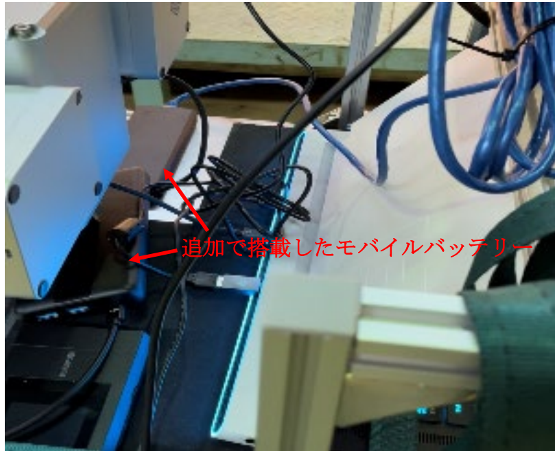
図 4.4-41 巡視点検ロボットに搭載されたバッテリー
