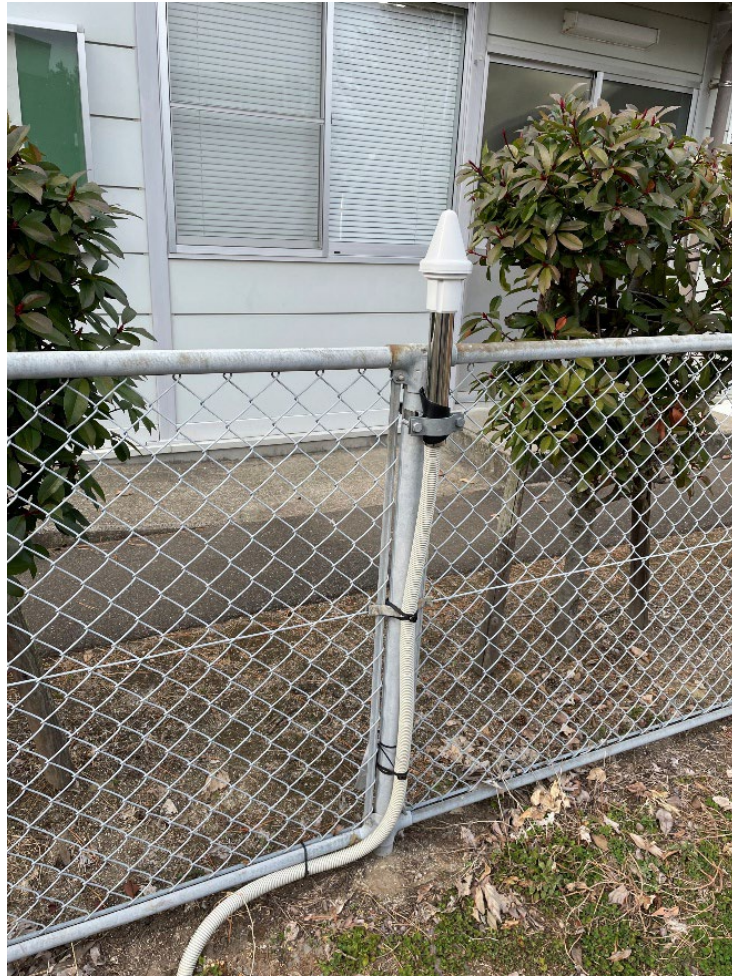
図 2.3-11 ローカル5G GPSアンテナ設置場所（室外）
