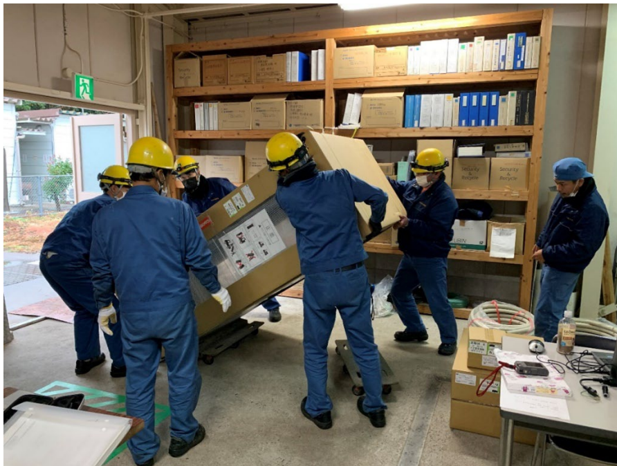
図 2.6-3 ローカル5G設備搭載用ラック設置状況
