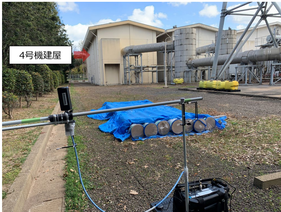
図 3. 2-2(b) 発電所建屋外観(写真撮影方向②)
