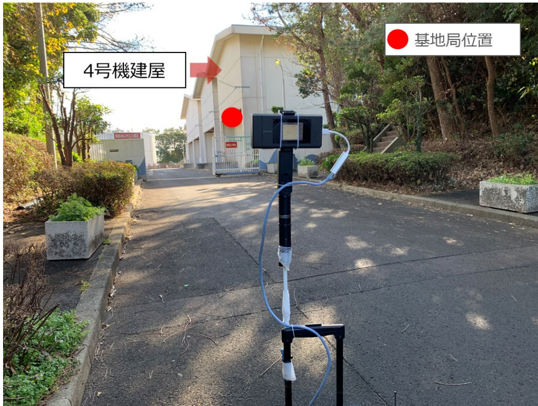
図 3. 3. 2. 1-2(a) 発電所建屋外壁(写真撮影方向①)
