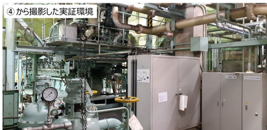
図 3. 2-2(c) 発電機、発電エンジン、発電設備の状況
