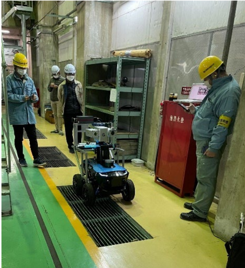
図 2.6-6 立会いによる作業
