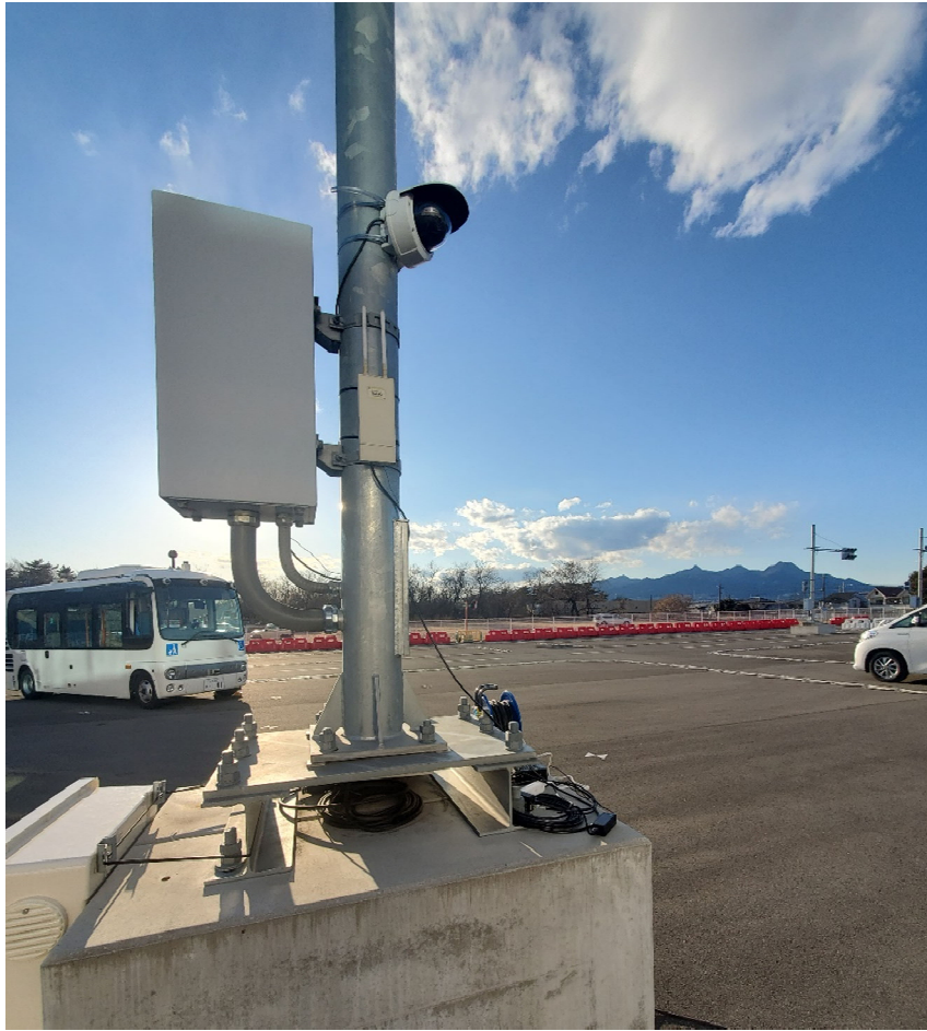
図 4-51 試験路における路側連携機器の取り付けの様子
