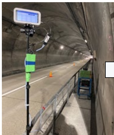
4K監視カメラ設置
