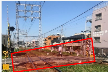
踏切全体をカバーし、異常検知 およびリアルタイム監視
