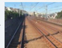
リアルタイムの現地映像を事務所で確認
