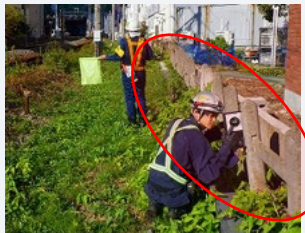
柵垣等の倒れ・変状
