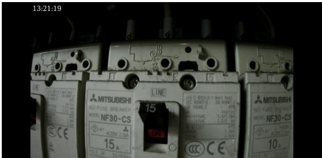
図 4.2.6-4) 制御盤の一部を 4K カメラで撮影した様子
