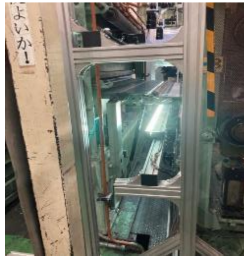
図 4.1.3-6) 取り付け台座下部(接近)
