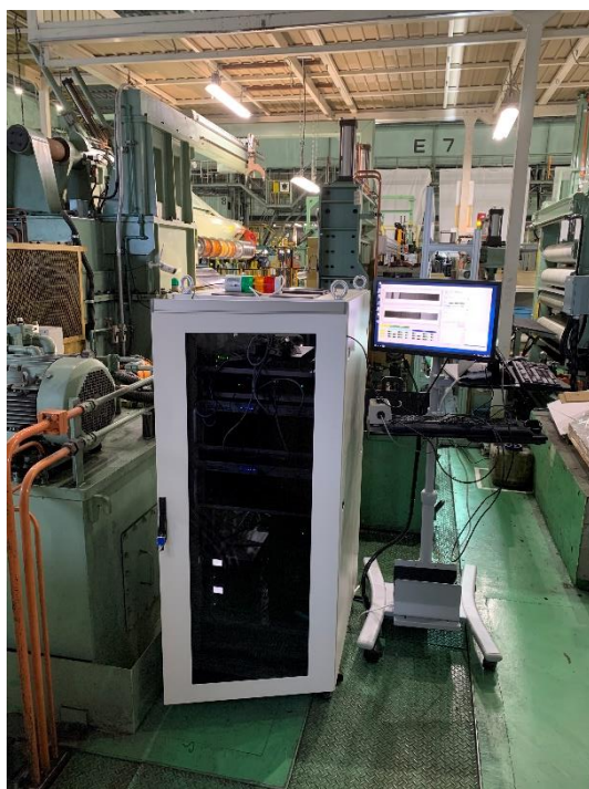
図 4.1.3-16) 現場に設置したサーバラック (現物)
