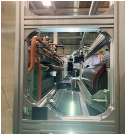
図 4.1.3-5) 取り付け台座上部(接近)
