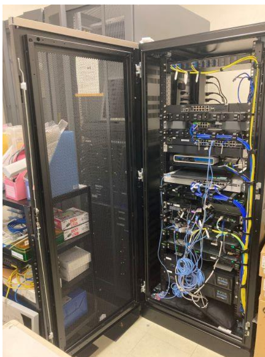
図 4. 1. 3-24) 電算室に設置したサーバラック (AI サーバも設置)
