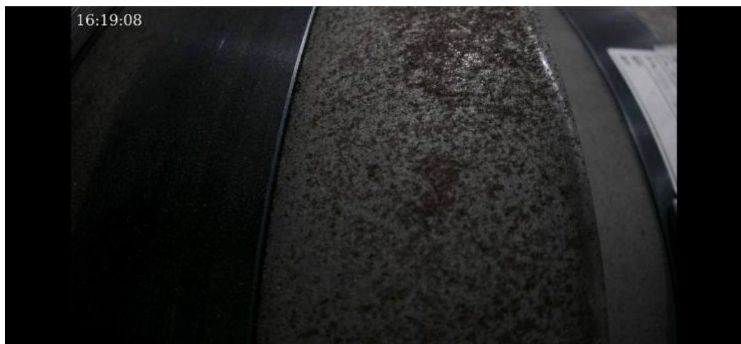
図 4.2.5-1) 長期滞留在庫の鋼板表面に発生した「錆」
