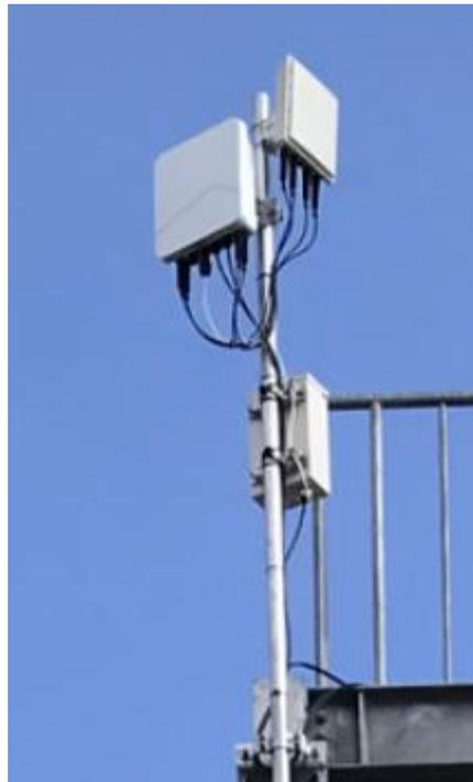
図 5.2.5-5 送受信機（2 段目）とアンテナ（最上段）
