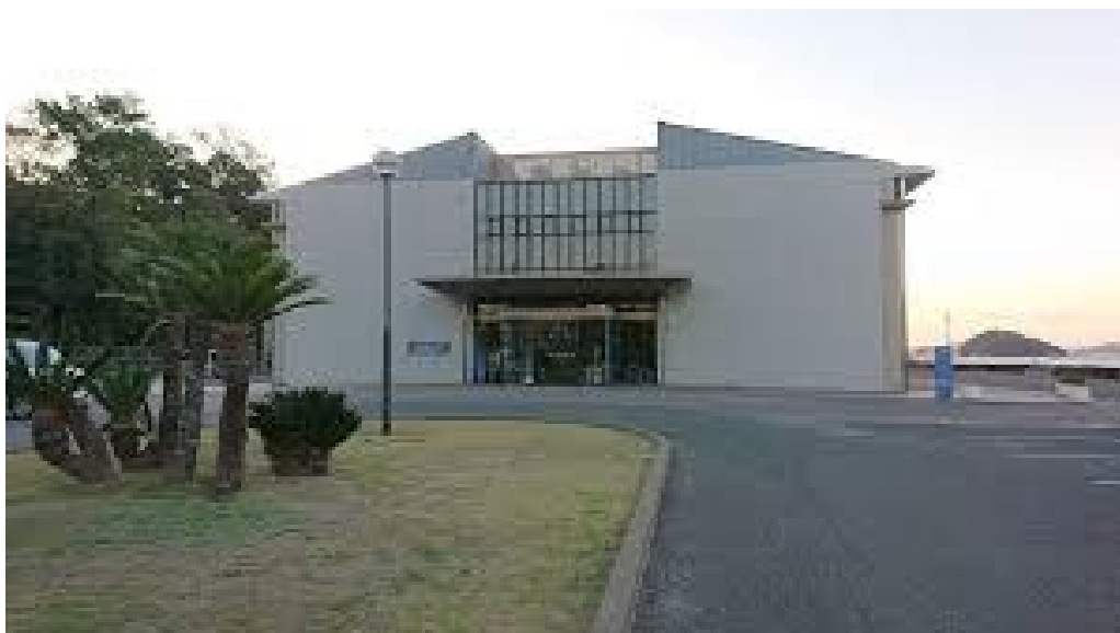
図 58 広島県立水産海洋技術センター
