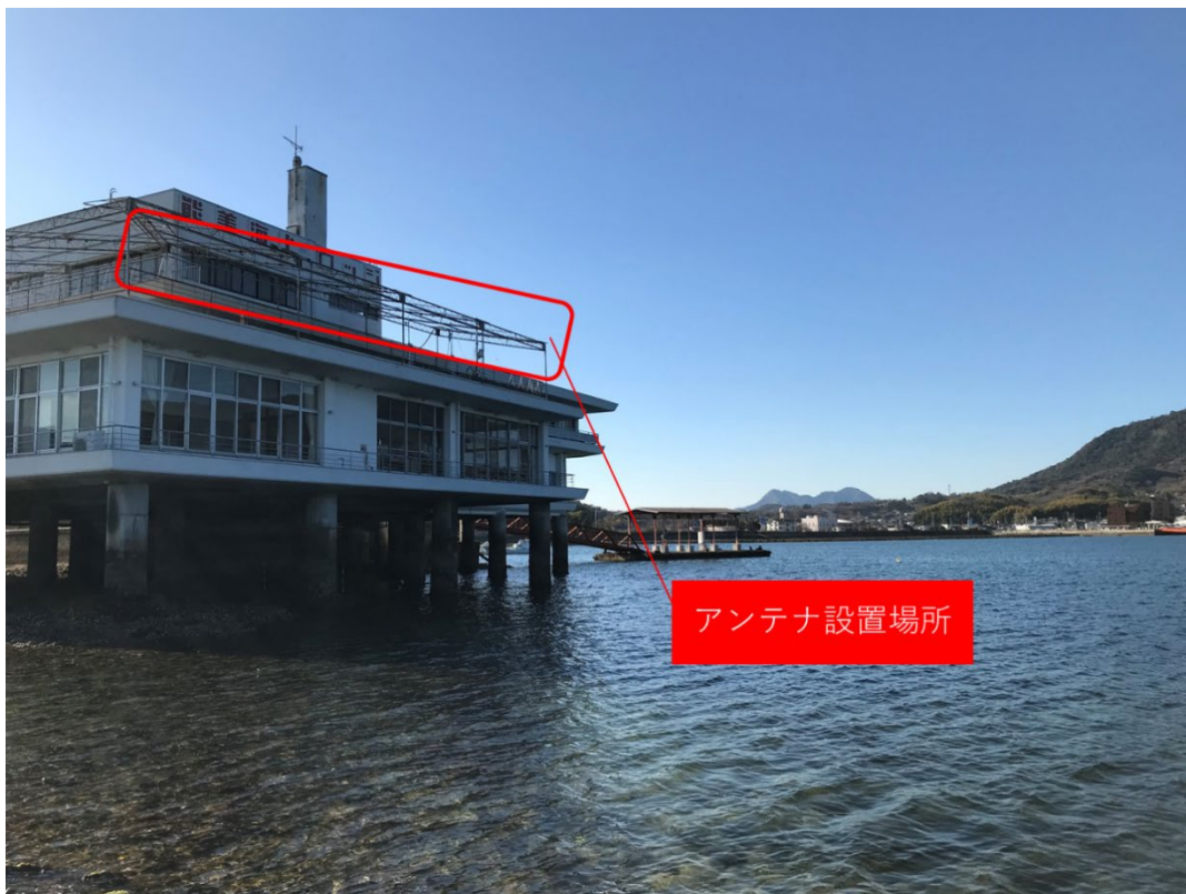
図 159 アンテナ設置場所
