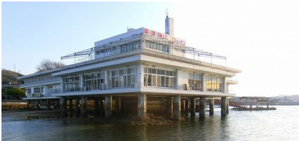
図 54 ローカル5G基地局を設置する能美海上ロッジ
