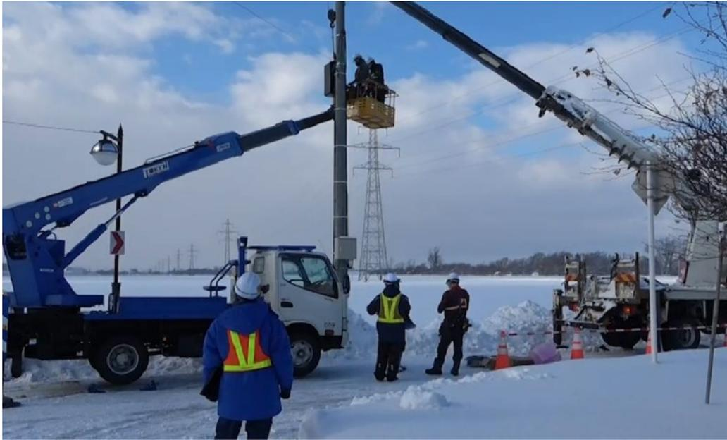
図 5.1.6 ローカル 5G 基地局設置工事
