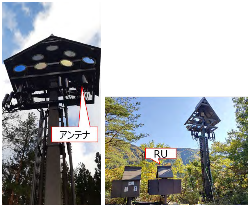
(a) 白川鳩谷局 基地局装置
